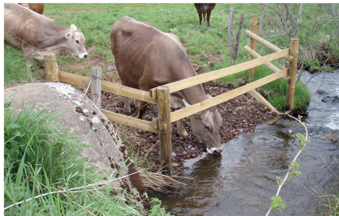
Abreuvoir réalisé par le SMVVA permettant l'abreuvement des animaux tout en préservant le cours d'eau
