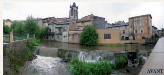
Aménagement d'un seuil aux Martres-de-Veyre (abaissement et passe à poisson).
